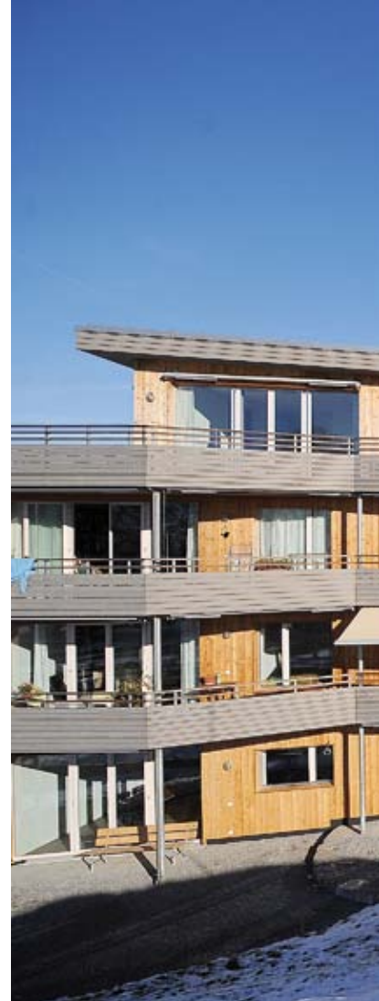
Prägnanter Holzbau: Verschiedene Hölzer, geknickte Fassaden und durchgehende «Zickzackbalkone» sorgen beim Block C im Oberfeld für Dynamik.
